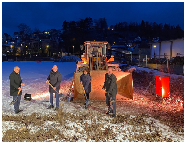
Abb. 24: Spatenstich für den Neubau.
